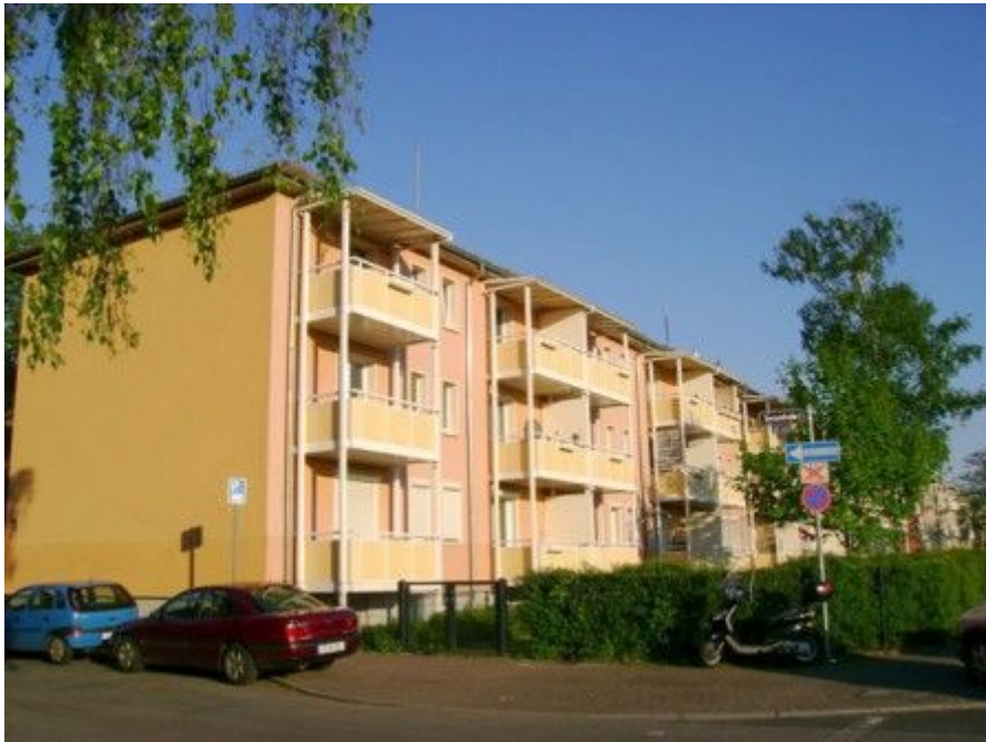
Szomszédos épület, nem passívház standard szerint felújítva.
