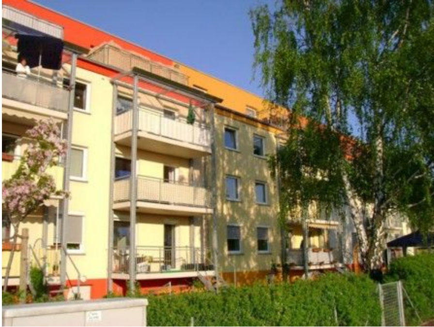
Passzívház standrad szerinti felújítás. Építészet: Faktor 10
