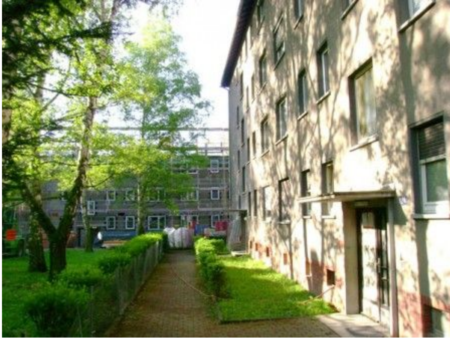
A régi épület, háttérben az átépítés alatt álló szárny
