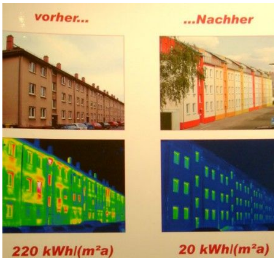
Hőfénykép a felújítás előtt és után
